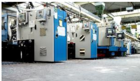
Bild 4: Blick in die Fertigungshalle bei Heinrichs & Co. KG Bildnachweis: Grieshaber GmbH & Co. KG
